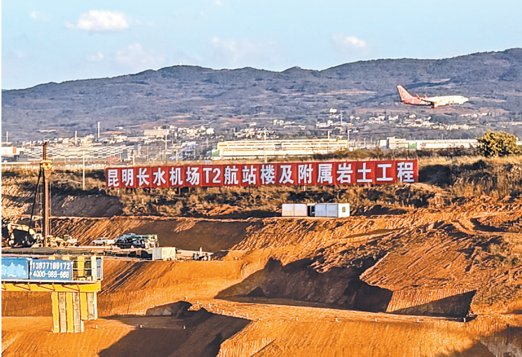
昆明长水国际机场改扩建项目T2航站楼及附属岩土工程施工现场。 本报记者 喻劲猛 摄
