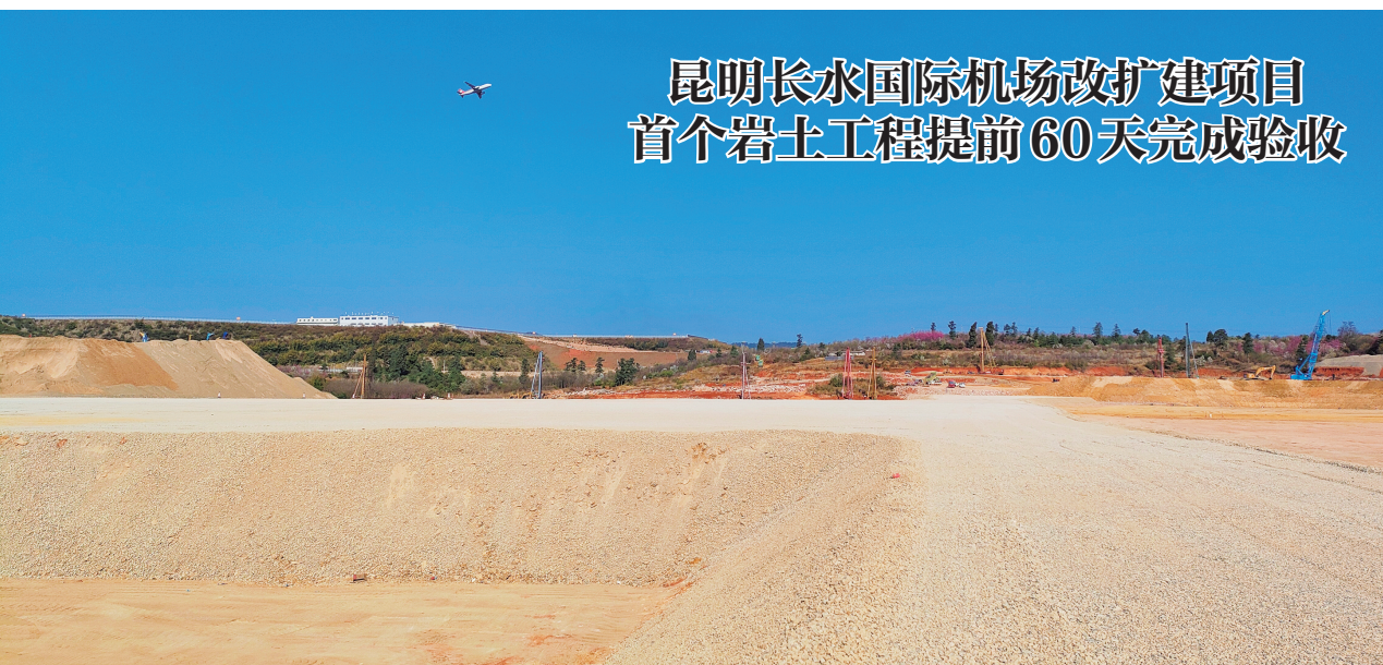
昆明长水综合交通枢纽—交通换乘中心(GTC)配套工程岩土工程一角。
