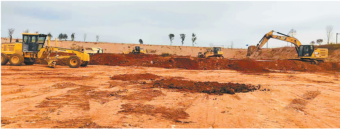
项目建设现场。
