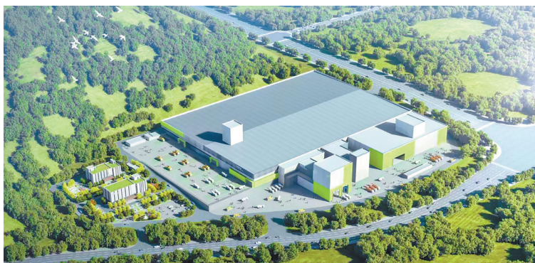
滇中新区建筑资源循环综合利用项目效果图。 本版图片均为供图
