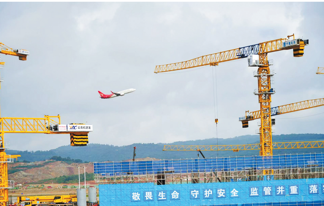
云南机场建设发展有限公司的 5G 塔吊。 通讯员 潘泓摄
