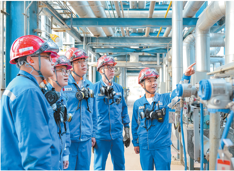
工作人员巡查设备运行情况。 通讯员 黄晓洪 摄
