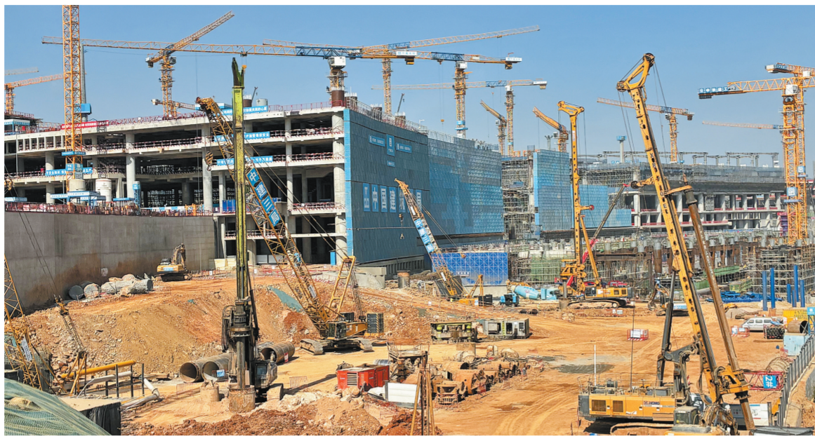
项目施工现场。
