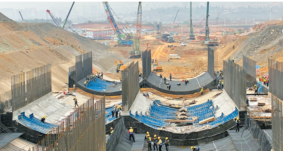
项目施工现场。
