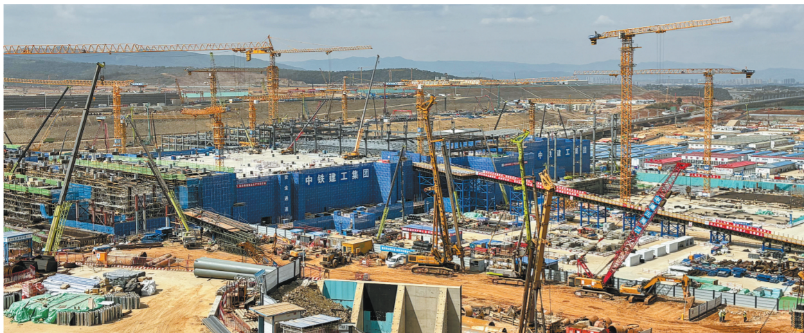
昆明长水国际机场改扩建工程建设现场。
